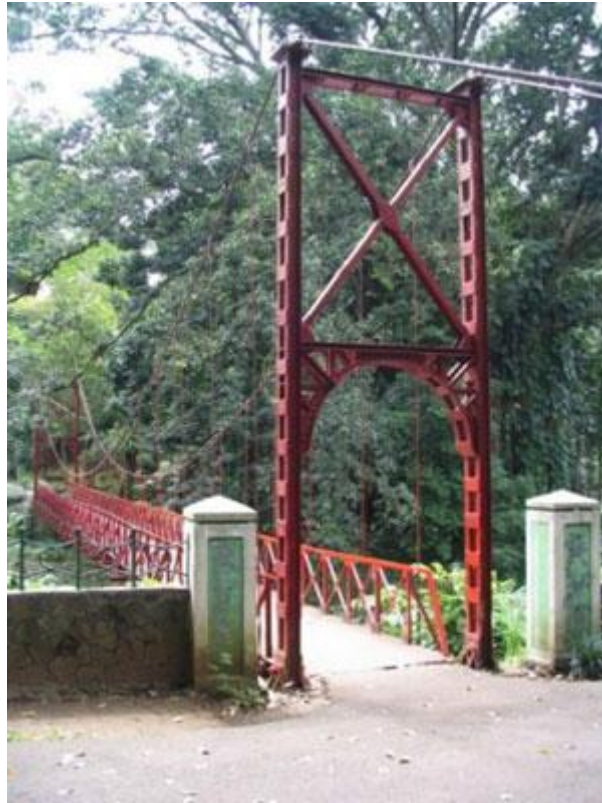
Jembatan yang melintasi Kali Ciliwung di Kebun Raya Bogor
